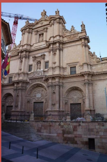
Главный портал церкви Святого Патрика выполнен в стиле барокко. Этот фасад является одним из наиболее ярких фасадов в регионе Мурсия.
